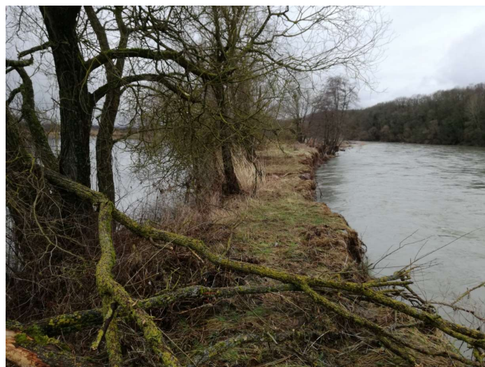
Berge séparant le Grand Rozot (à gauche) de la Moselle (à droite), début 2018
