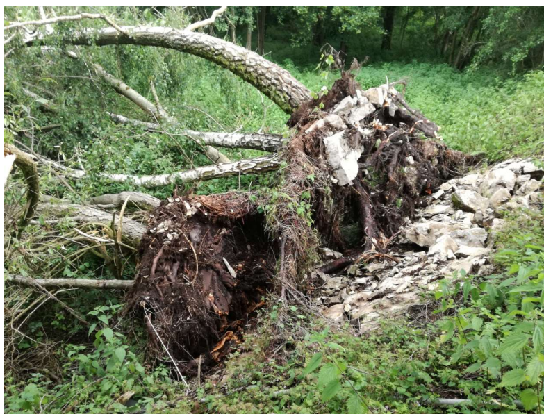
Digue du chenal de crue dégradée par la chute d'arbres
